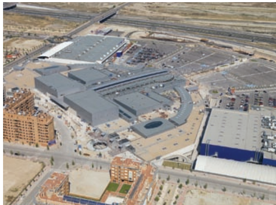
Carrefour, próximo de Madrid, uma das obras da Omnitrade
