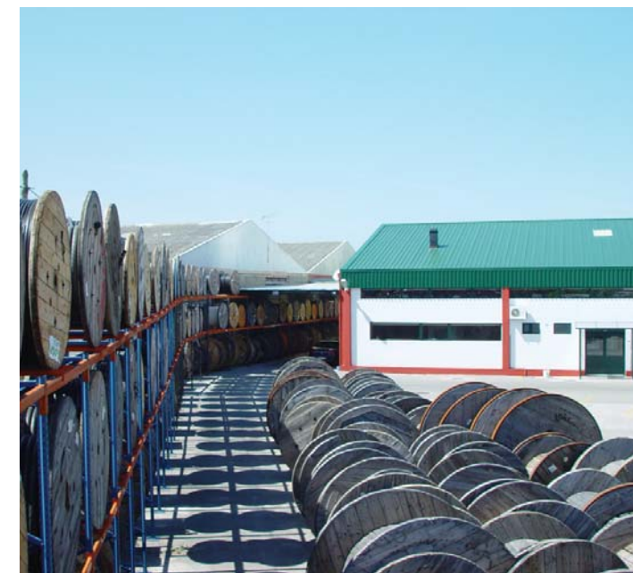
Instalações do armazém central da Eurocabos, perto de Lisboa
