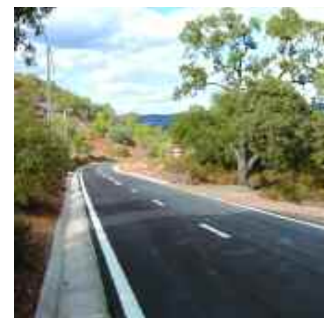
Estrada construída pela Algarstradas, uma das empresas do grupo Manuel Rodrigues
